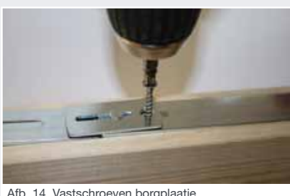
Afb. 14 Vastschroeven borgplaatje
