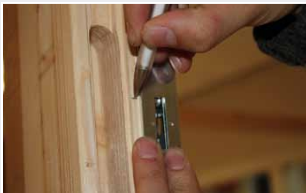
Afb. 9 Haaksparing gelijk aan afgetekende Sluitplaat
